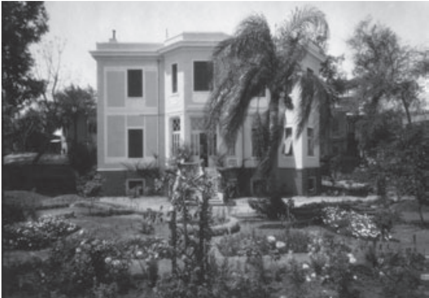
Abb. 2: Gartenansicht der Institutsvilla in Zamalek, Kairo, 1924 (© Schweizerisches Institut für Ägyptische Bauforschung und Altertumskunde, Kairo).
